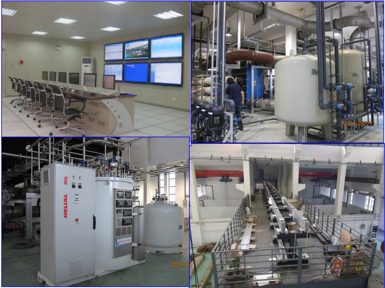
各技术装备系统安装调试
